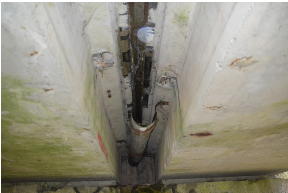
Obr.F80-20 Konec pole č.2. Pravá fasáda nosníku č.1 (vlevo) levá fasáda nosníku č.2 (vpravo) v uložení na třetí podpěře, krnovské opěře. Pohled proti směru staničení a vzhůru,
