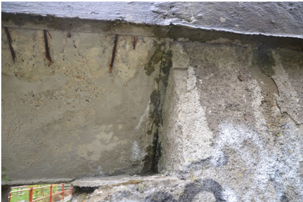
Obr.F80-05 Začátek levé, povodní fasády železobetonové desky v uložení na první podpěře, olomoucké opěře. Pohled zleva doprava, proti vodě,
