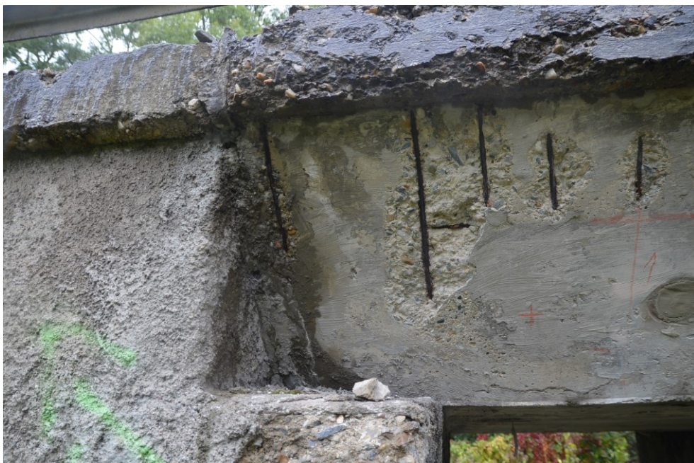
Obr.F80-11 Začátek pravé, návodní fasády monolitické železobetonové desky v uložení na první podpěře, olomoucké opěře. Pohled zprava doleva, po vodě,
