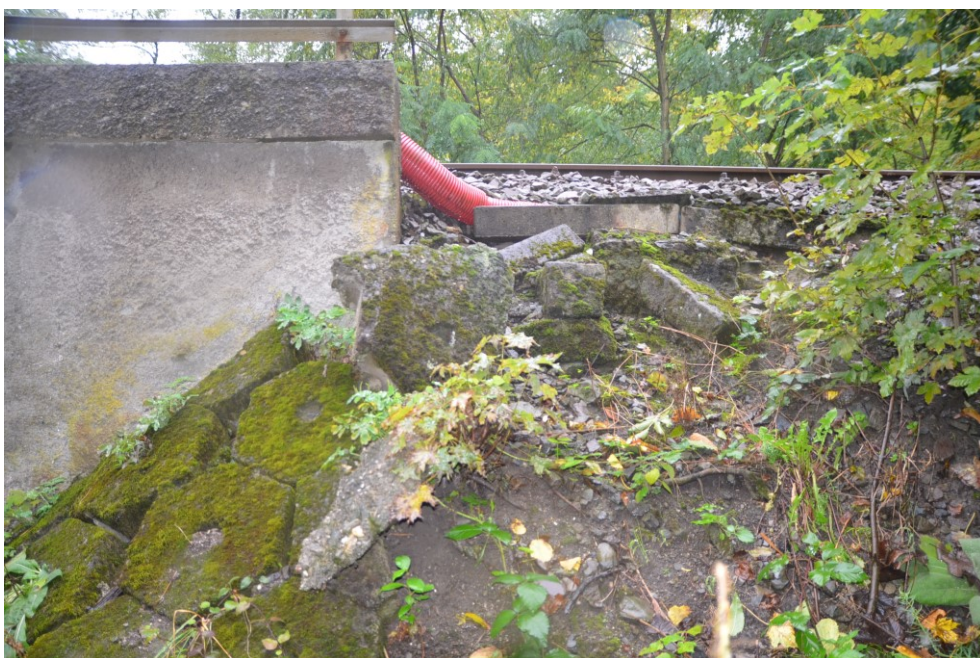
Obr.F80-30 Detail zpevnění svahu při pravém křídla třetí podpěry, krnovské opěry. Pohled zprava doleva, - opevnění z betonových (šestiúhelníkových) tvárnic se místy rozpadá a neplní tak svou funkci.
