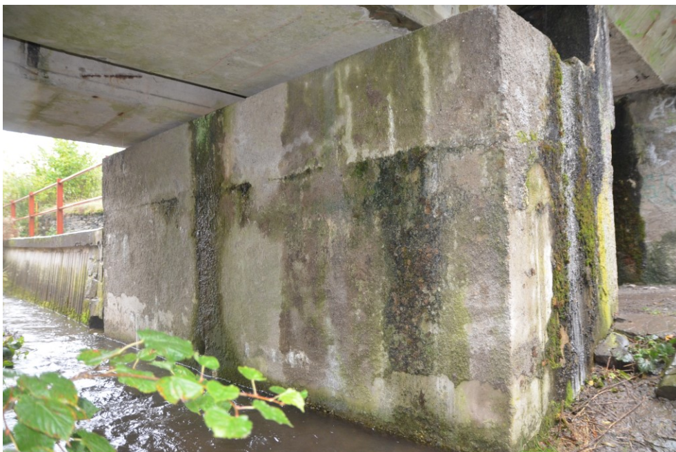
Obr.F80-29 Druhá mezilehlá podpěra. Pohled zleva doprava, proti vodě a proti směru staničení, - úložný práh a dřík druhé mezilehlé podpěry výrazně zamáčen z důvodu nefunkčního MZ a odvodnění podélné spáry mezi nosníky, - uchycení mikroorganismů vlivem dlouhodobého zatékání.
