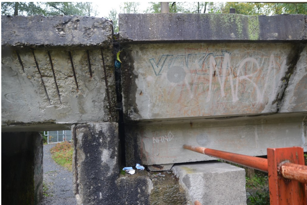
Obr.F80-13 Pravá, návodní fasáda v místě uložení NK na druhou, mezilehlou podpěru. Pohled zprava doleva, po vodě,
